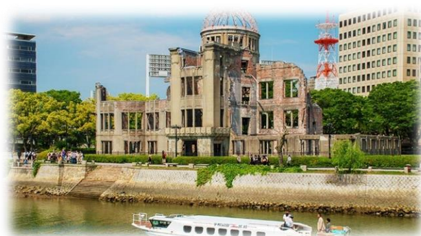
Le bâtiment « rescapé » du bombardement.
